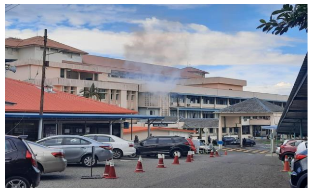
Gambar 1: simulasi asap di wad maternity blok bangunan lama.
